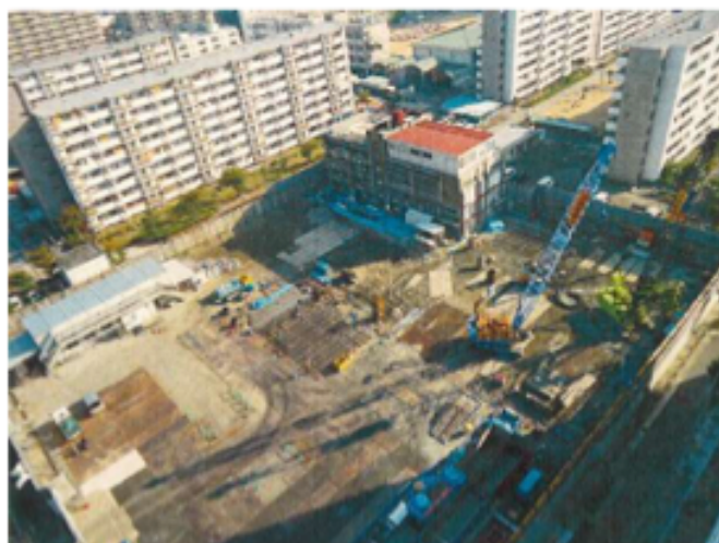
旧病院解体工事
