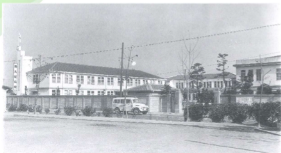
新築になった産婦人科病棟（左側）
