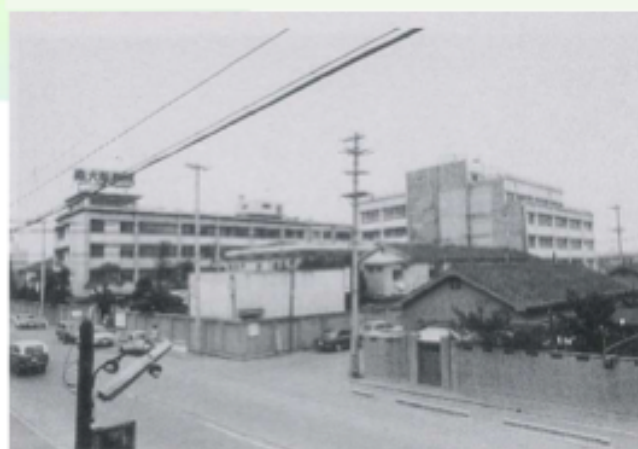
第4期工事完成(東病棟：写真右奥)
