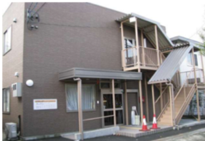
南大阪病院附属 リハビリテーションクリニック
