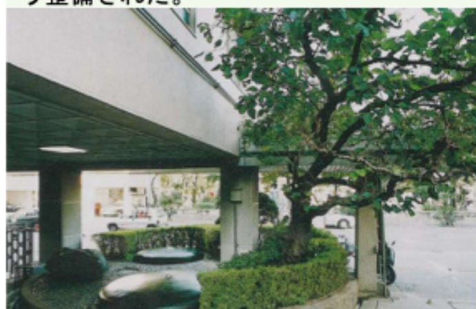
南病棟 正面玄関付近
