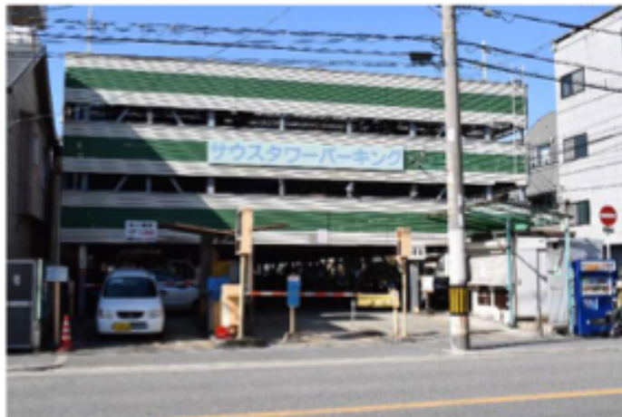
サウスタワーパーキング
