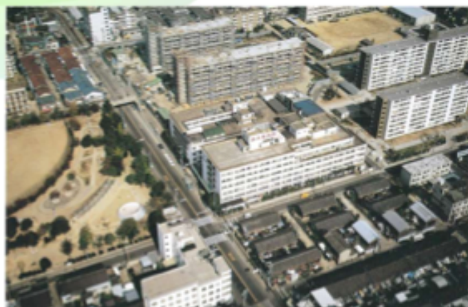
南大阪病院全景、下手は看護婦寮
